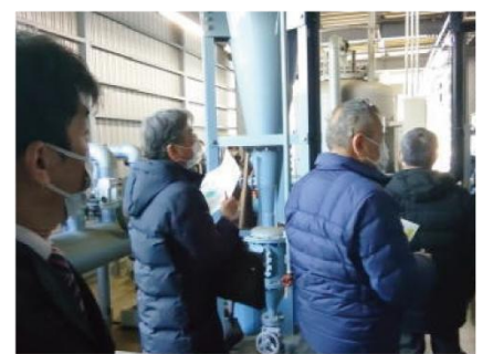
委員長を努めた委員会で明石の湯の改修案に対応。現場視察も。
