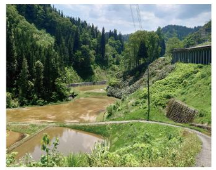
災害現場の確認（松之山 2022 年 5 月）
