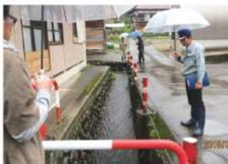
松代区内の現場を確認、改修要望
