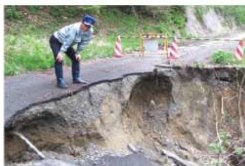
被災現場を確認、早期改修を要望（奴奈川地区）
